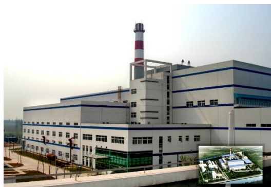
南通区域生活垃圾焚烧热电联产工程 中国第一座区域生活垃圾焚烧厂
