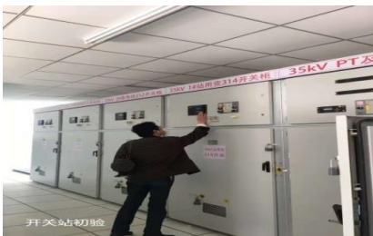
安矿光伏项目
