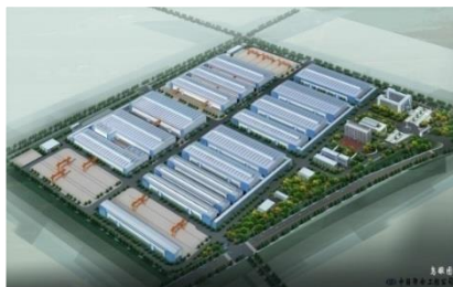
固镇光伏项目
