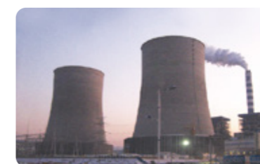
山西, 左权, 间接空冷系统
