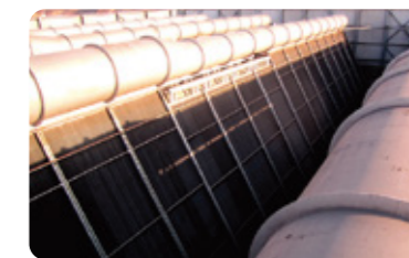
山西, 中钰, 直接空冷系统改造
