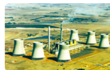
南非, 肯达尔, 间接空冷系统
