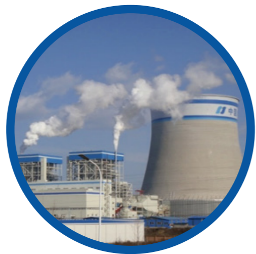
华电杨凌(2x350MW) 项目采用烟塔合一 直径161m，高180m 2015年12月双投，已取得PAC
