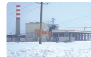
内蒙古, 鄂温克, 直接空冷系统
