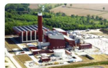
意大利直接空冷系统联合循环电厂
