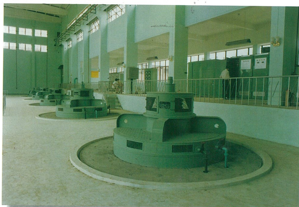
图 4. TL 系列 1600 千瓦 20 极立式同步电动机 Fig. 4 The TL 1600kW 20P vertical synchronous motor.
