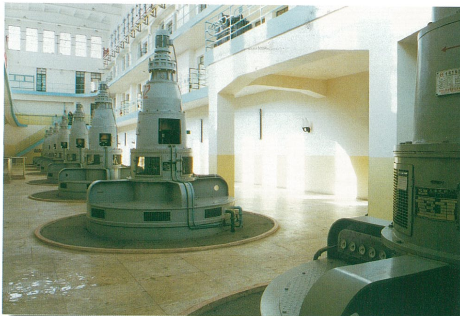
图 2. 图为改造后的安装在江苏省江都排灌站的 TL 系列 1000 千瓦 24 极同步电动机
