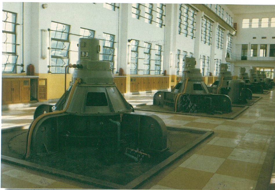
图 1: 安装在江苏省江都排灌站的 TL 系列 3000 千瓦 40 极同步电动机。
