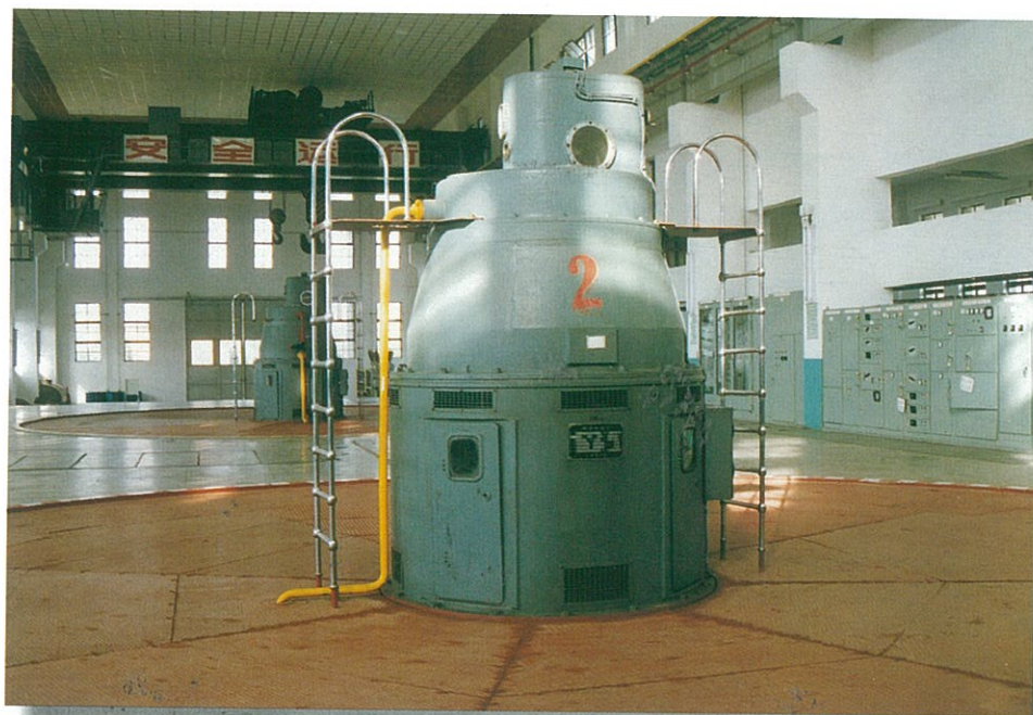
图 3 安装在江苏省皂河泵站的最大功率的 TL 系列 7000 千瓦 80 极同步电动机 Fig.3 The largest TL 7000kW 80P synchronous motor installed in the Zaohe pump station, Jiangsu province.
