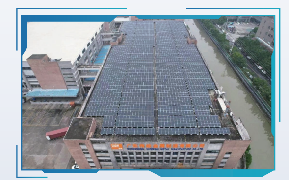
广东蔚盈科技1.2MW光伏项目 Guangdong Weiyang Technology 1.2MW PV project
