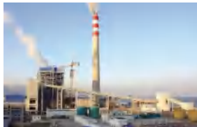
广东阳西电厂AGC储能调频项目
