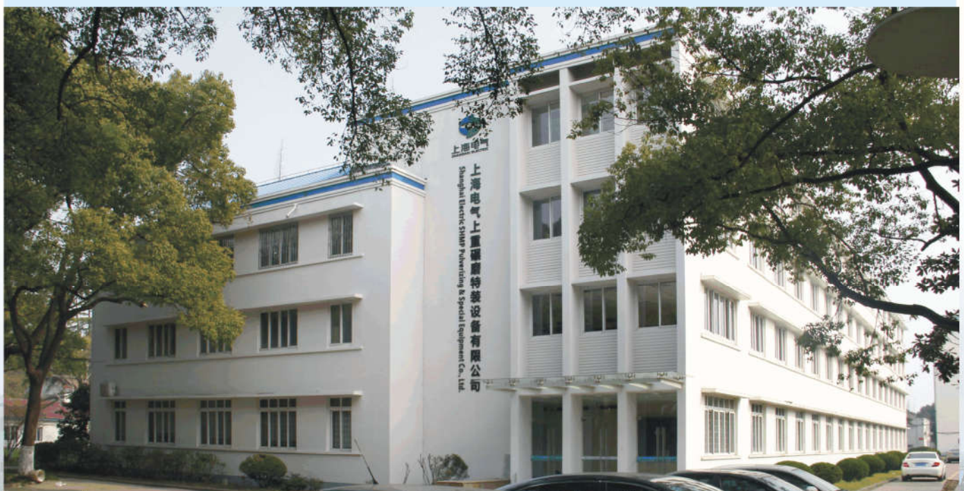
上海重碾磨特装公司办公楼 office building of SEHPS
